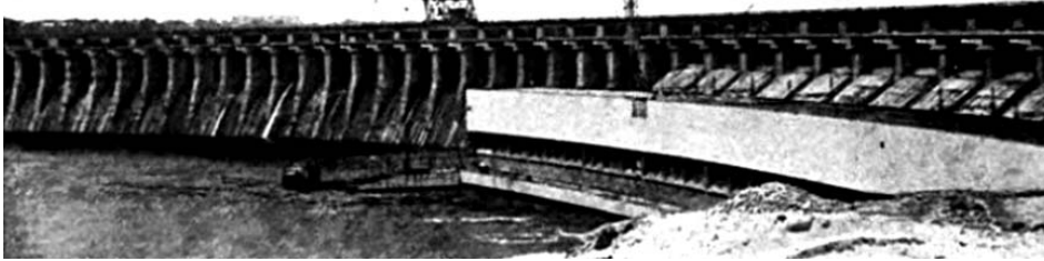
Лівобережна частина дамби з будівлею машинного залу ДніпроГЕС-2.
