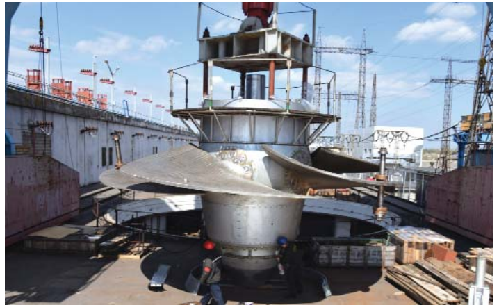
Монтаж робочого колеса турбіни гідроагрегату.
